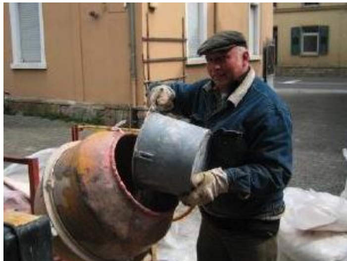
Bild 12: Herr Gemeindearbeiter Gerd Zink am Betonmischer.
