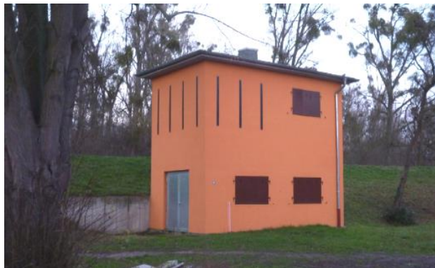
Bild 3: Schöpfwerk Oppenheim von 1933 bis 1976.
