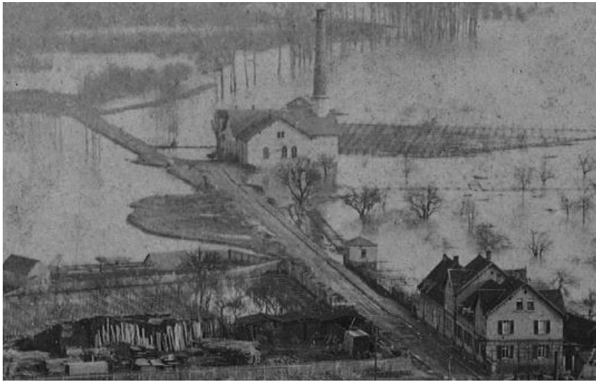
Bild 2: In der Bildmitte das Betriebsgebäude der ersten Wasserhebeanlage (sog. Oppenheimer Wassermaschine) im Jahr 1876 75 (dort steht heute die Bäckerei Reuter).
