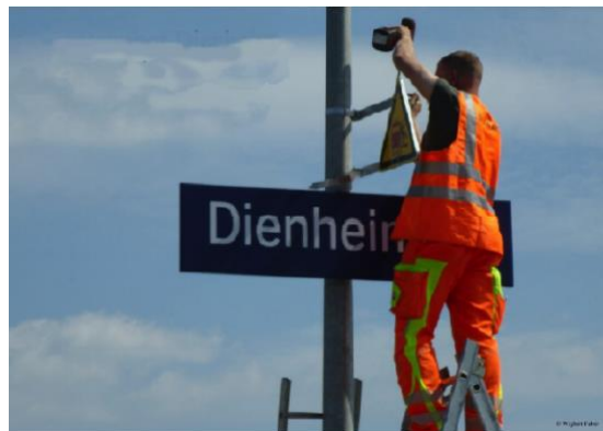
Bild 4: Bahnhof Dienheim am 14. April 2015 61 .
